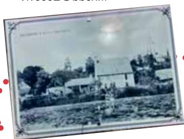
Muret Rue du Val
