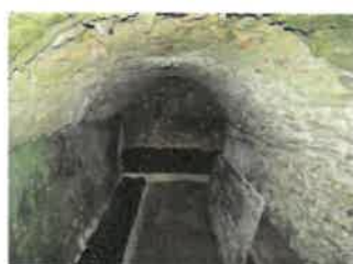
Illustration 1: Création d'un effondrement dû à la présence d'une cavité souterraine (modifié d'après MEED)
